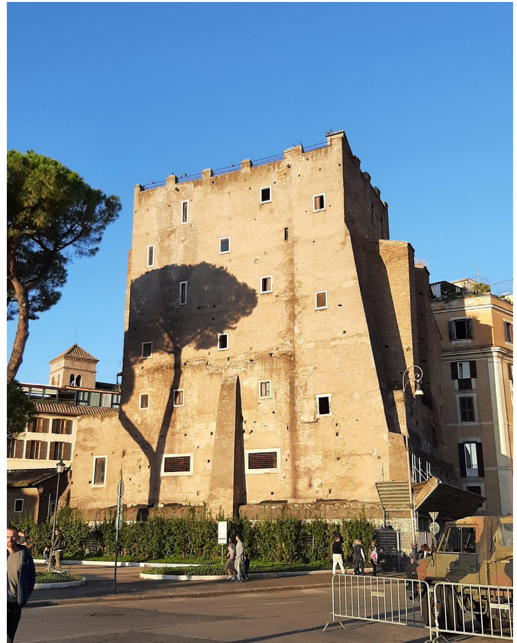
Fig. 52 - The actual remains of the Torre dei Conti.
